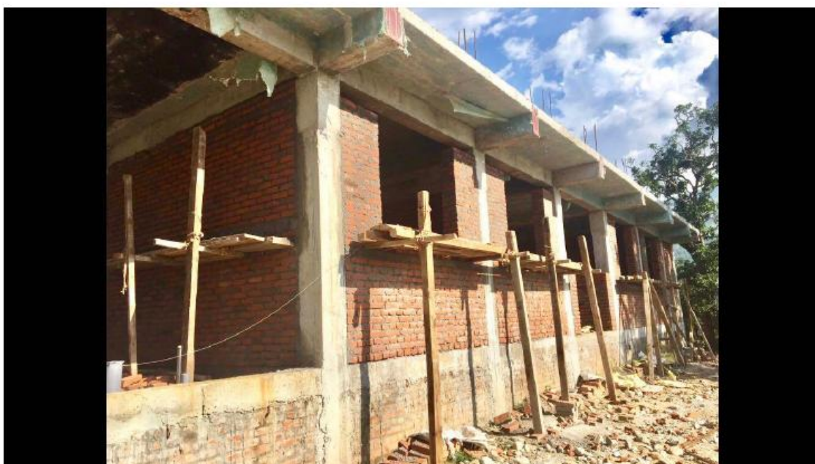
Bodgaun: il Centro medico in costruzione – stato dei lavori a dicembre 2017
